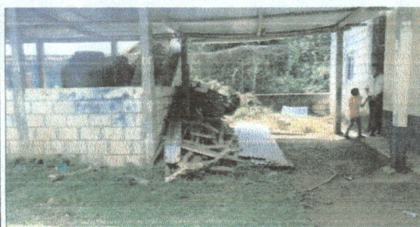
FOTOGRAFIA 3: Se observan las áreas no adecuadas para el proceso de enseñanza y aprendizaje.
