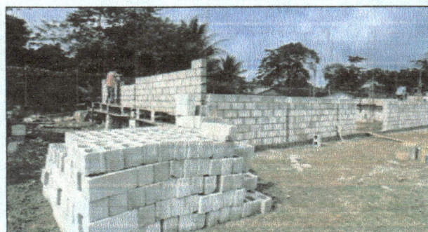
FOTOGRAFIA 4: Los miembros de la comunidad por iniciativa propia iniciaron con la construcción de un modulo de dos aulas, por lo que se espera que con la ayuda del programa de mantenimiento se pueda culminar para habilitar el lugar.
