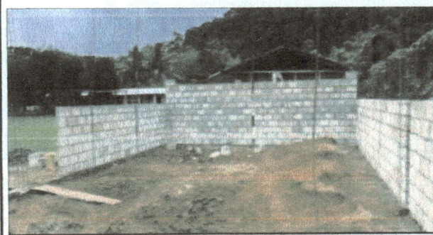
PASO 5. Vista de las paredes del aula reparadas por la comunidad.
